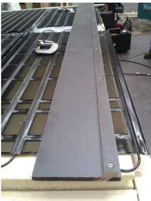
FIGURE 1.13 – Découpe des planches sur les côtés (en contre-plaqué marin de 12 mm d'épaisseur et 15 cm de largeur. Découpe et fixation de petites lattes afin de maintenir le verre.
