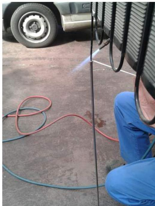
FIGURE 1.8 – Soudures de rallonge pour connecter les condenseurs du haut aux collecteurs.
