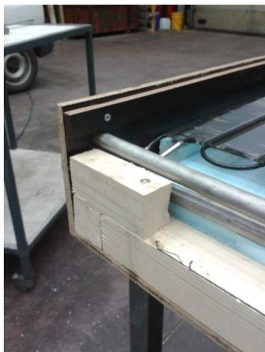
FIGURE 1.14 – Fixation des côtés et des condenseurs afin qu'ils ne bougent pas. Rajout d'isolant pour combler les trous.
