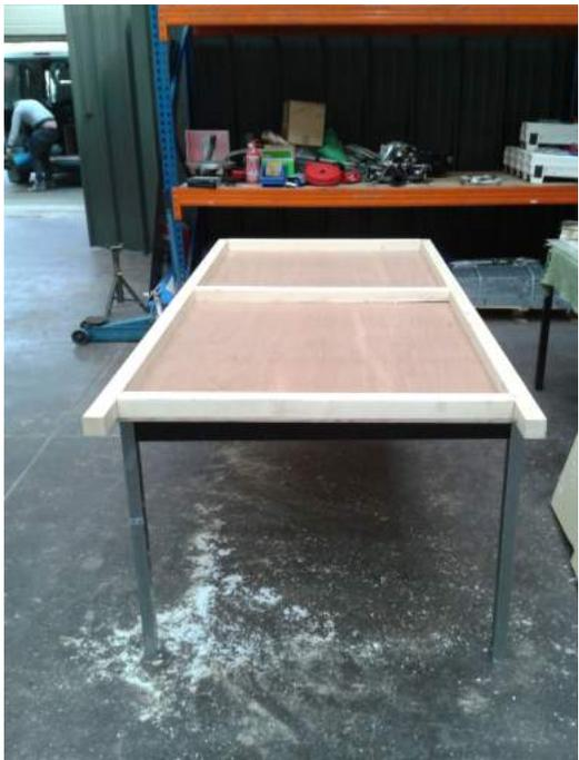
FIGURE 1.2 – Découpe et fixation sur la planche des poutres 46\*46 mm pour servir d'armature et renforcer ainsi le panneau.
